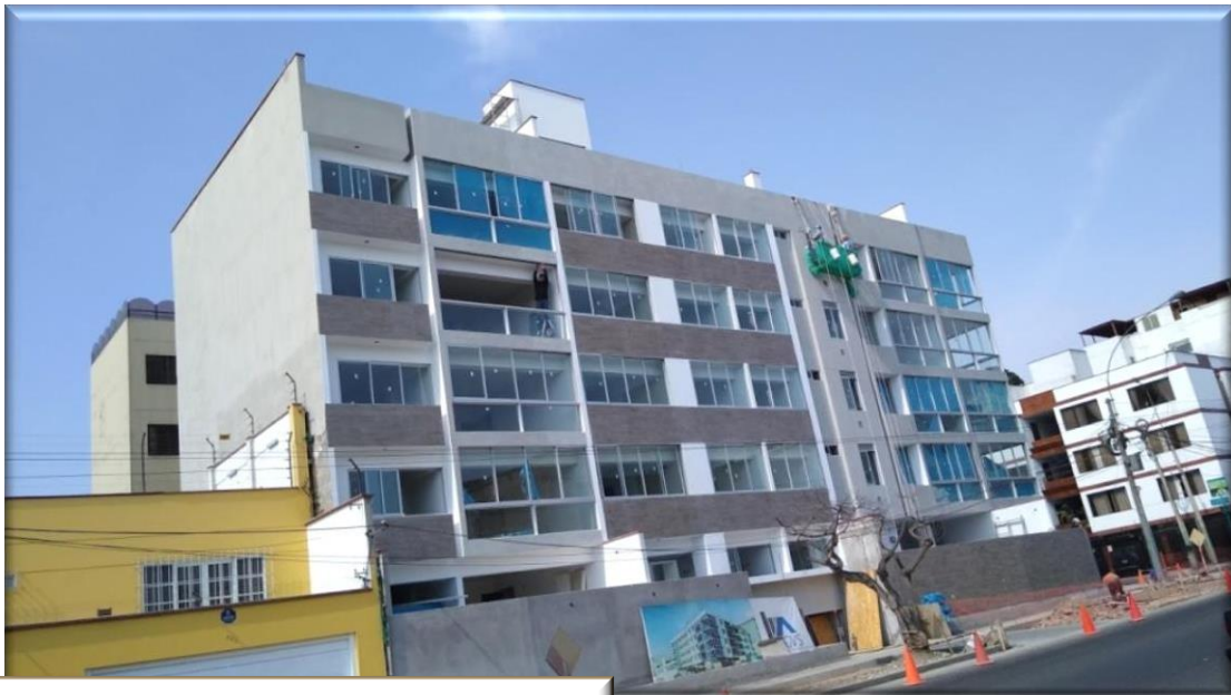
Obra San Borja
